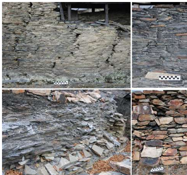
Fig. 17 – Los efectos de la actividad sísmica en el Chao Samartín se advierten sobre toda su trama edificada con brechas y deformación de paramentos, línea de fragmentación de mampuestos y cabalgamiento del sustrato rocoso sobre el muro desplazado.
