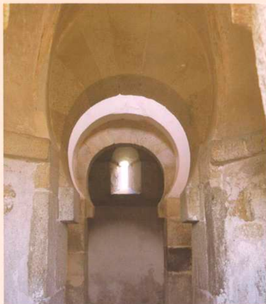
Imagens do interior e exterior da capela de S. Miguel, em Celanova
