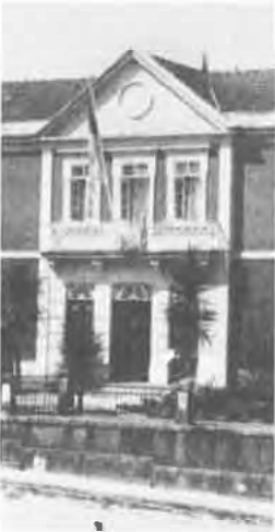
Instalações do antigo hospital de Santo Tirso.
