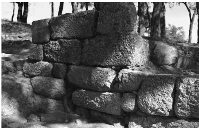
Est. VII – Vista parcial do alicerce da face leste e paramento do alçado principal da igreja.
