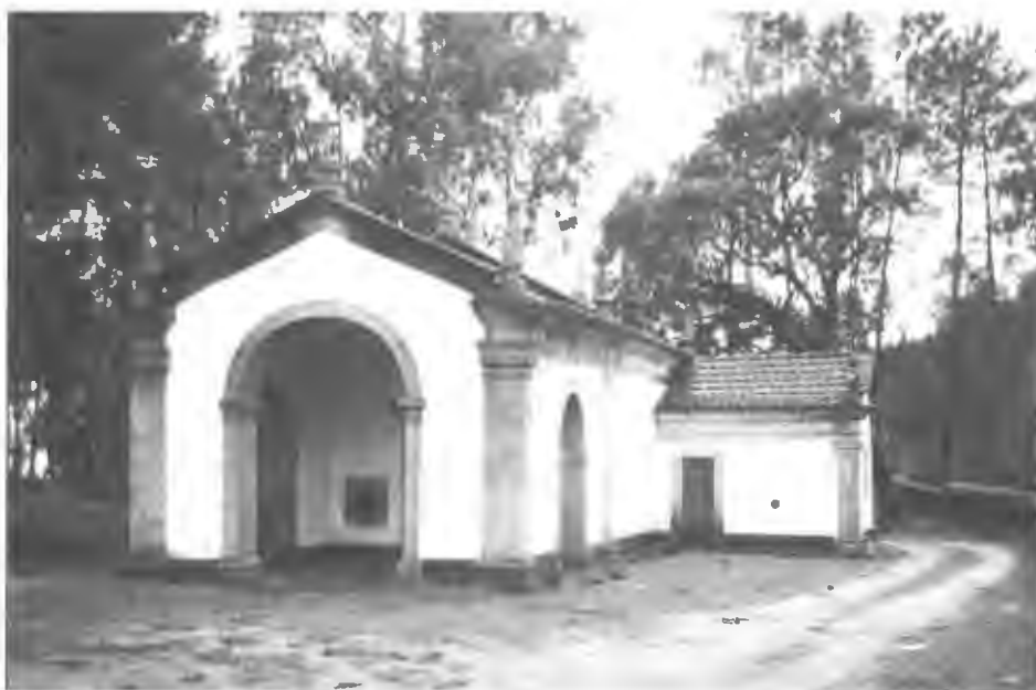
Fotografia da capela Fachada e alçado lateral Norte
