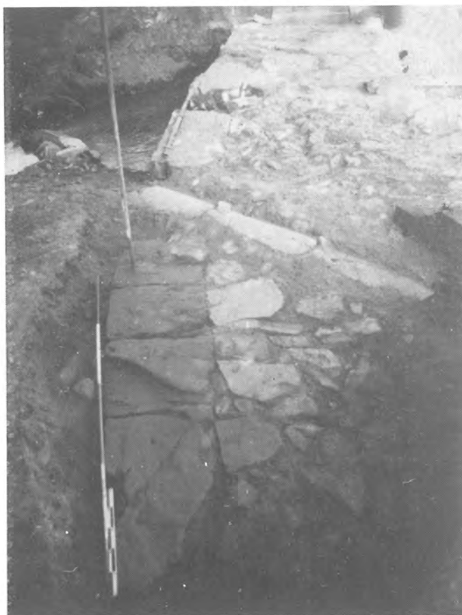
2 - Pontão do Arquinho, vista geral do tabuleiro e calçada.
