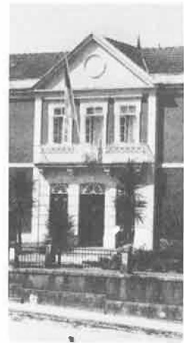
Instalações do antigo hospital de Santo Tirso.
